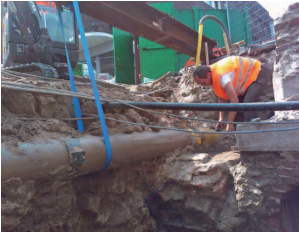
De aanzet van de stenen boog over de Aa, was in augustus nog duidelijk aanwezig. Tijdens de werkzaamheden is deze uitgekapt (foto Theo de Jong).
